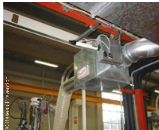
Caisson de filtration et registre de sélection du débit
