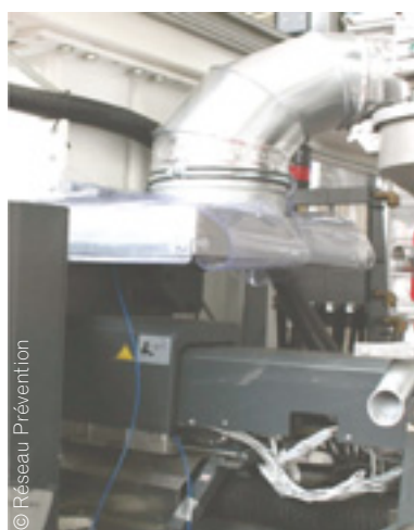
Dispositif de captage - Aucune bavette en place
