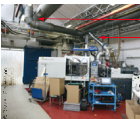
Connexion du système de captage au réseau de ventilation
