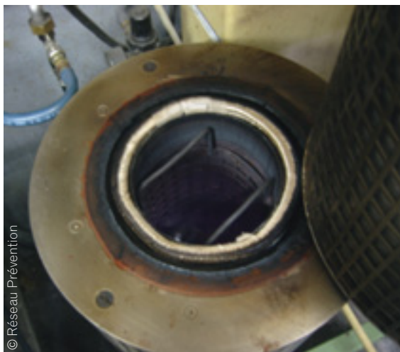
Chambre de chauffe inférieure
