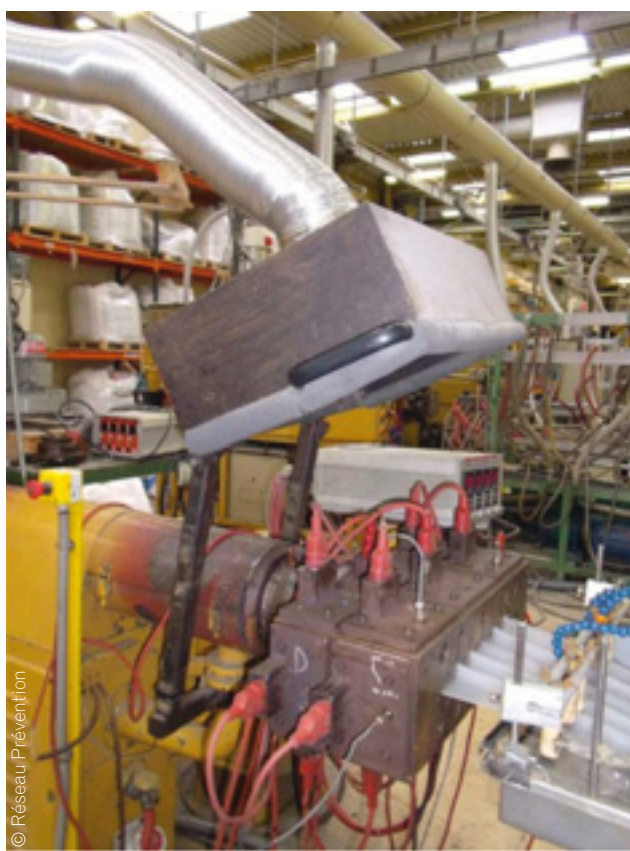
Hotte de captage inclinée
