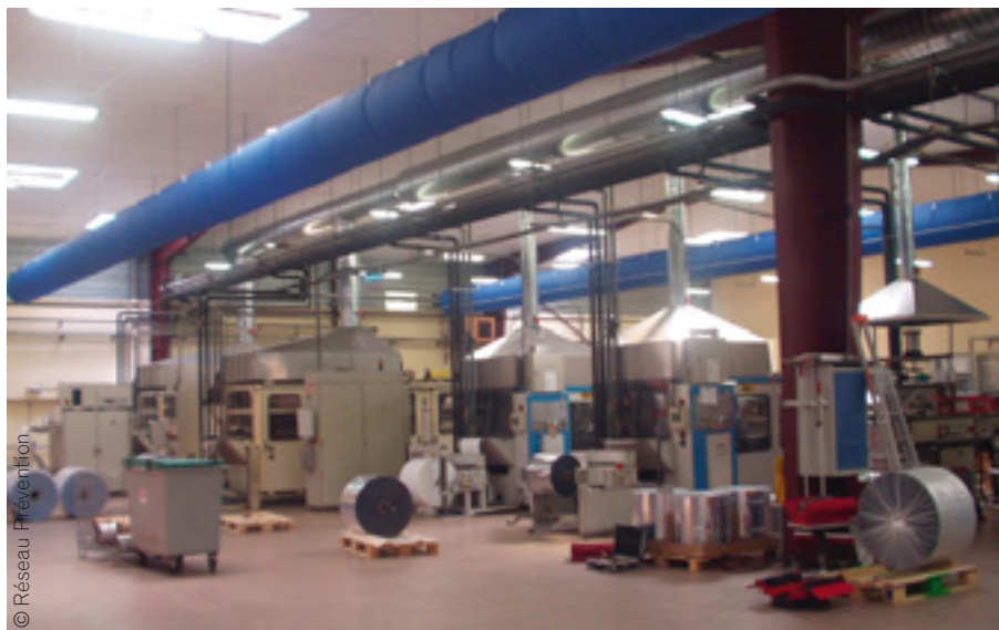
Vue générale de la ventilation de l'atelier
