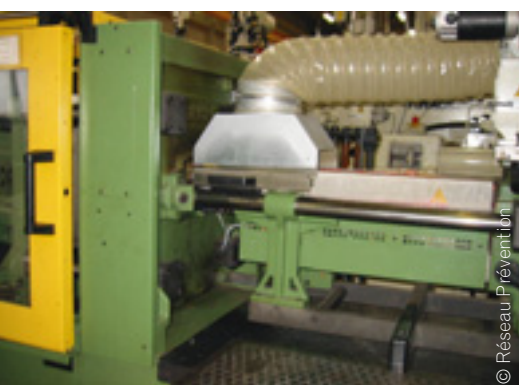
Hottes de captage
