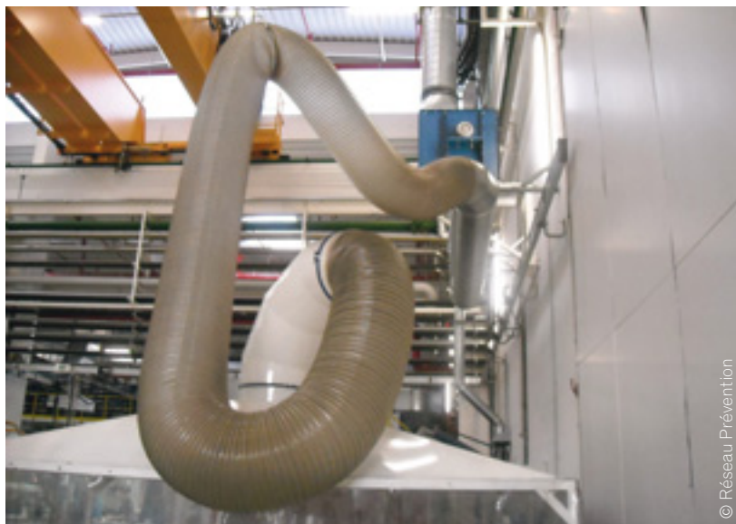
Conduit souple de raccordement de la cabine au ventilateur
