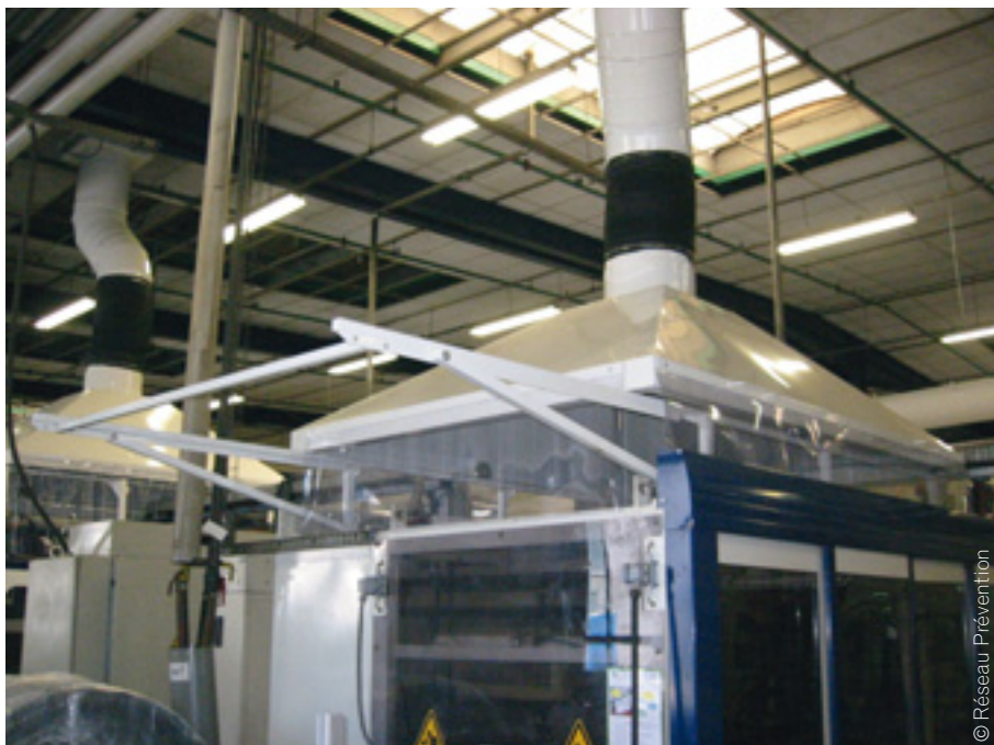
Hotte de captage
