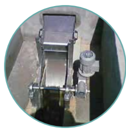
dégrilleurs automatiques
