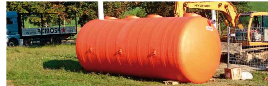
Réception de la station compacte - SBREM
