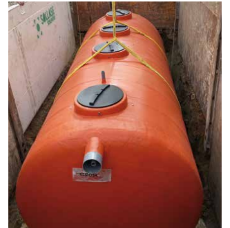
Installation dans la fouille
