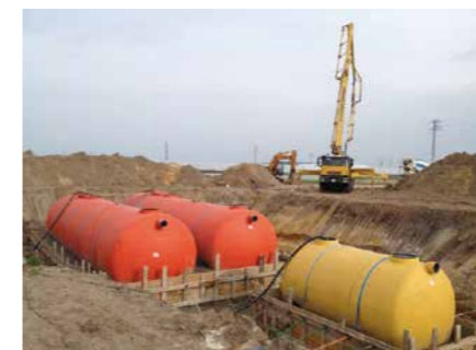
2 DECANROX 350 pour traiter des effluents du secteur des fraises
