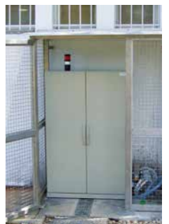
Abri préfabriqué qui protège de l'extérieur le coffret et le compresseur
